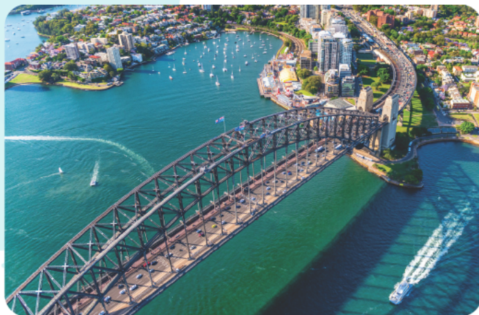
Sydney – Hardour híd
