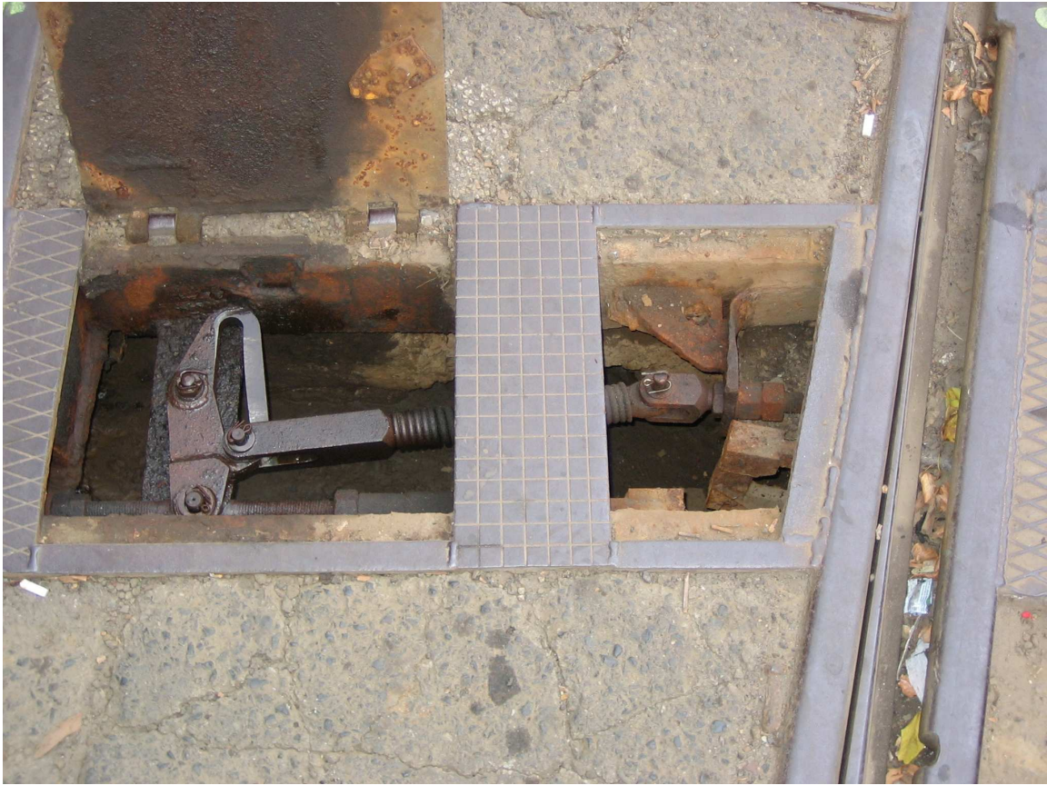
Nyomórugós váltóállító szerkezet átszelési kitérőben
