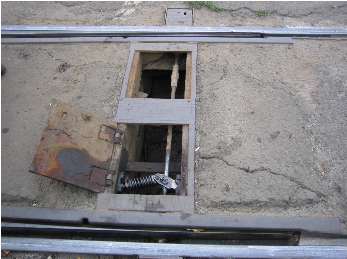
Nyomórugós váltóállító szerkezet
