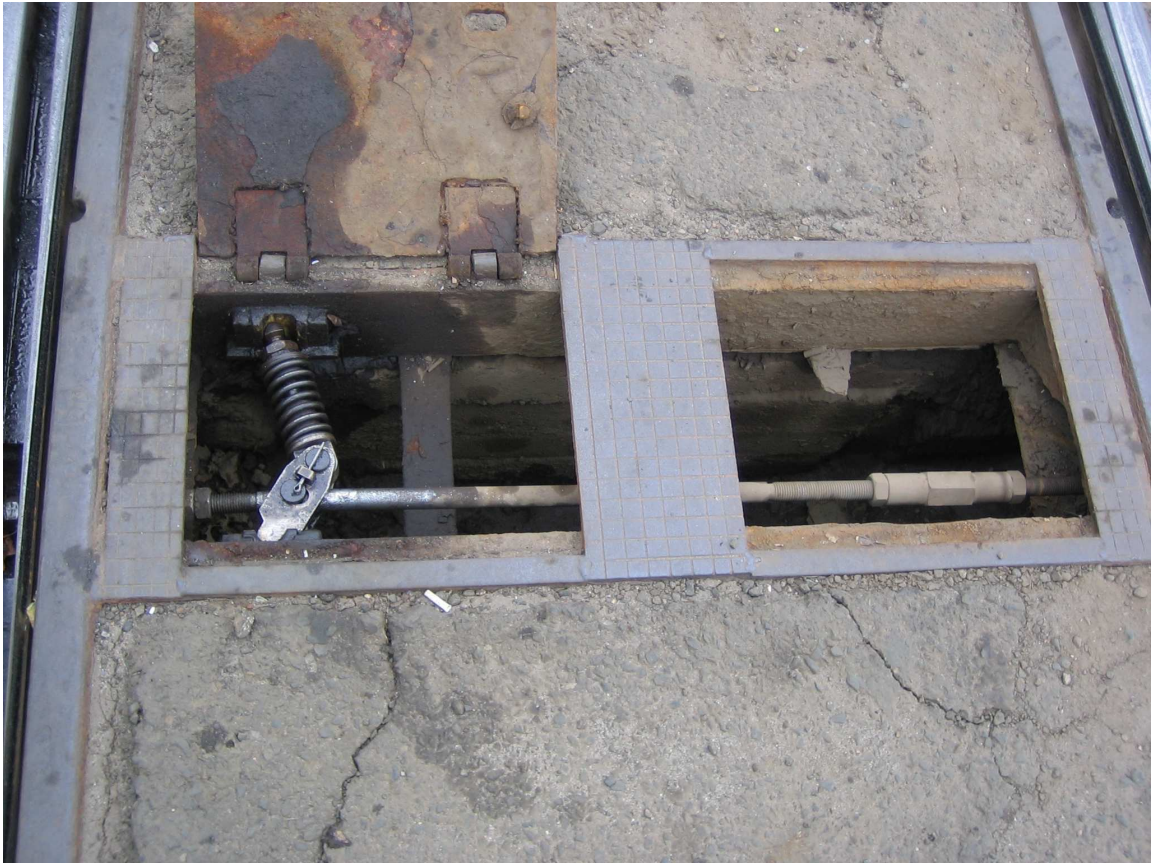
Nyomórugós váltóállító szerkezet
