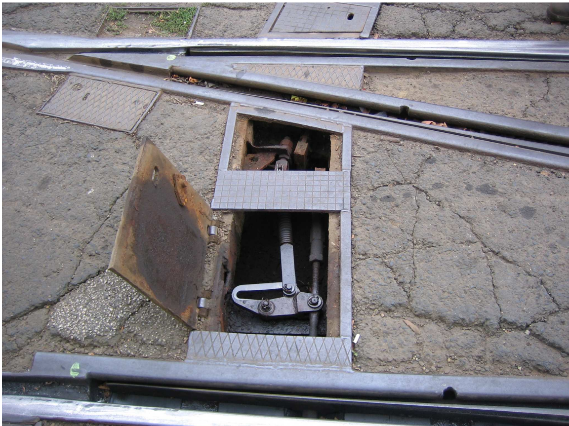
Nyomórugós váltóállító szerkezet átszelési kitérőben
