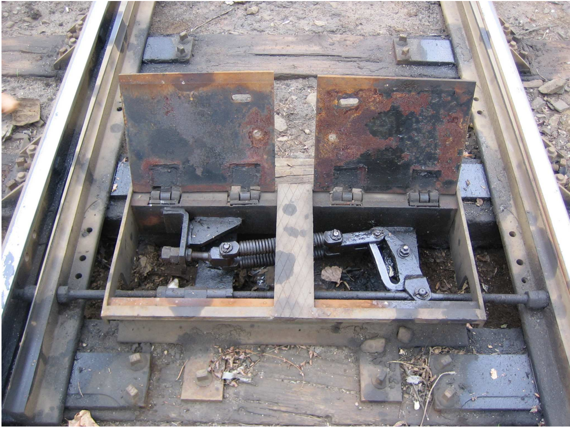
Húzórugós váltóállítómű 48-as rendszerű kitérőben
