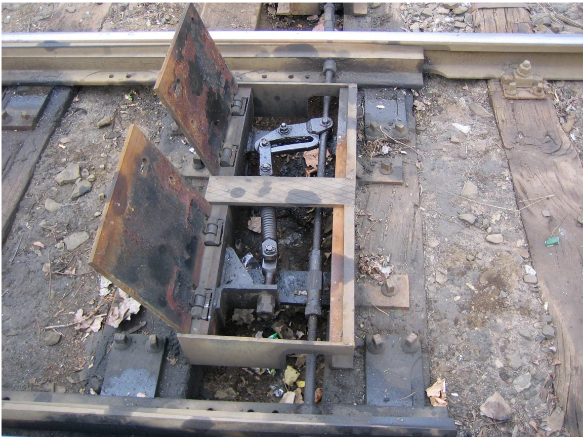
Húzórugós váltóállítómű 48-as rendszerű kitérőben
